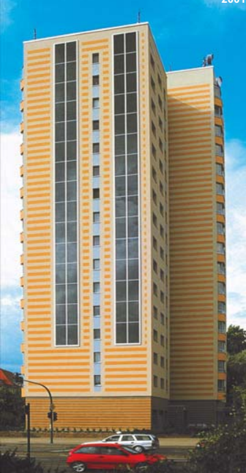
Immeuble à Potsdam Fonctionnement sans encombre depuis 2001
